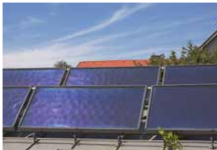
Horizontalkollektor mit Montagegestell 25°:
