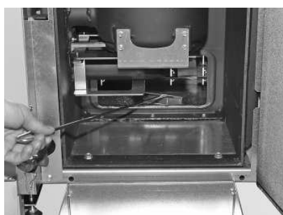
Fig. 50 Asche unter der Nachheizfläche in Aschelade entfernen
