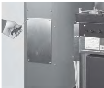
Fig. 78 Schrauben entfernen, Revisionsdeckel abnehmen
