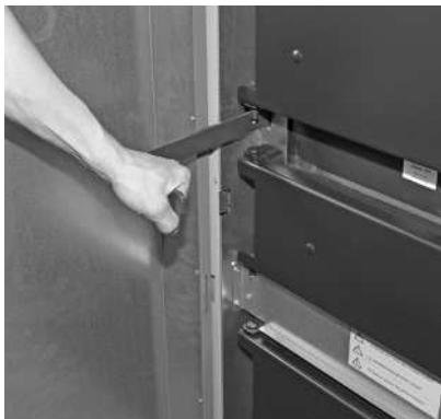
Fig. 14 Hebel-Heizflächenreinigung 5–10 x betätigen
