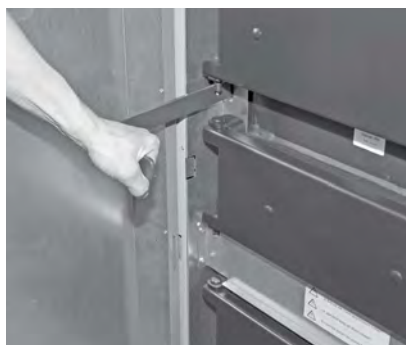
Fig. 30 Hebel-Heizflächenreinigung 5–10 x betätigen
