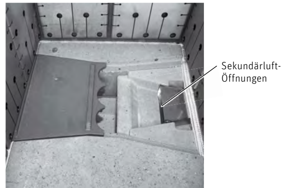
Fig. 43 Abbrandplatten herausnehmen, Sekundärluft-Öffnungen kontrollieren.
