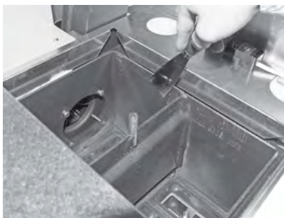
Fig. 73 Nachheizflächen reinigen
