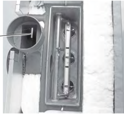
Fig. 40 Nachheizflächen oben reinigen
