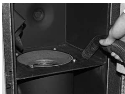
Fig. 55 Verbrennungsrückstände aus dem Brennraum entfernen
