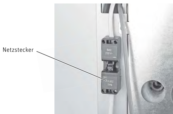
Fig. 35 Netzstecker abstecken
