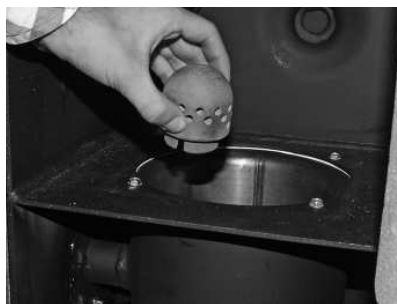
Fig. 61 Primärluftdorn herausnehmen
